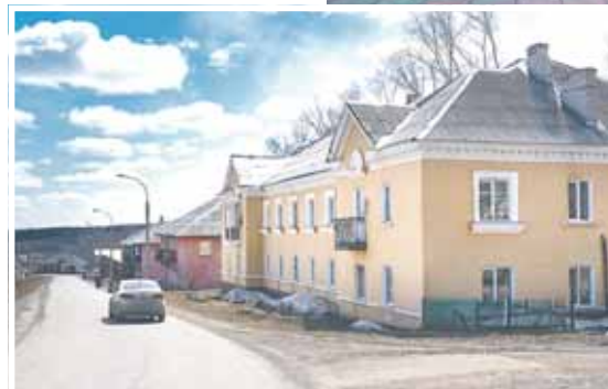
Все центральные дороги Пионера отремонтированы в 2019 году.
