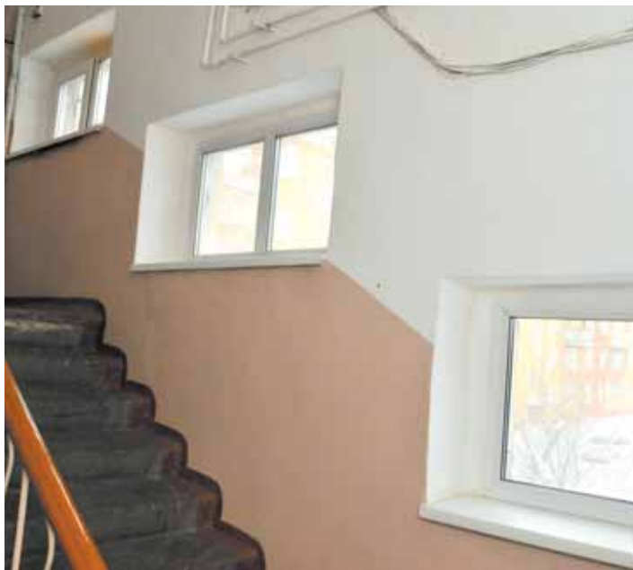
На фото: лестница в этом необыкновенном доме идет вдоль несущей стены – вот и загадка узких окошек по фасаду.
