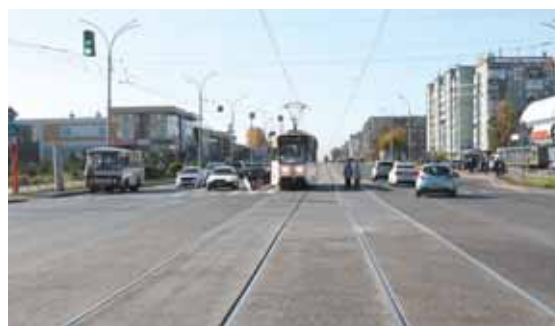
На фото: в рамках нацпроекта «Безопасные и качественные автомобильные дороги» в Рудничном районе капитально отремонтировали 27 автомагистралей.
